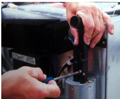
Demontáž vrchní části komínku
